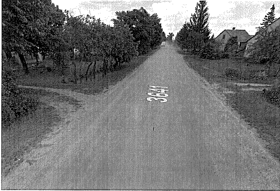
2 Pav. Nagrinėjamos sankryžos techninė būklė
